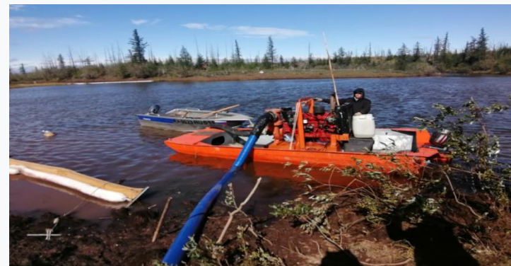
Откачка топливно-водяной смеси (Норильск 2020 г.)
