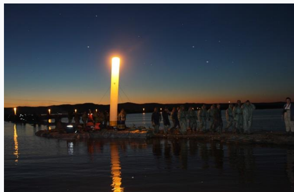
Установка земляной дамбы (Дальний Восток 2013 г.)
