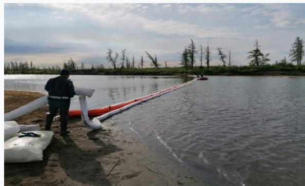
Установка сорбирующих боновых заграждений (Норильск 2020 г.)
