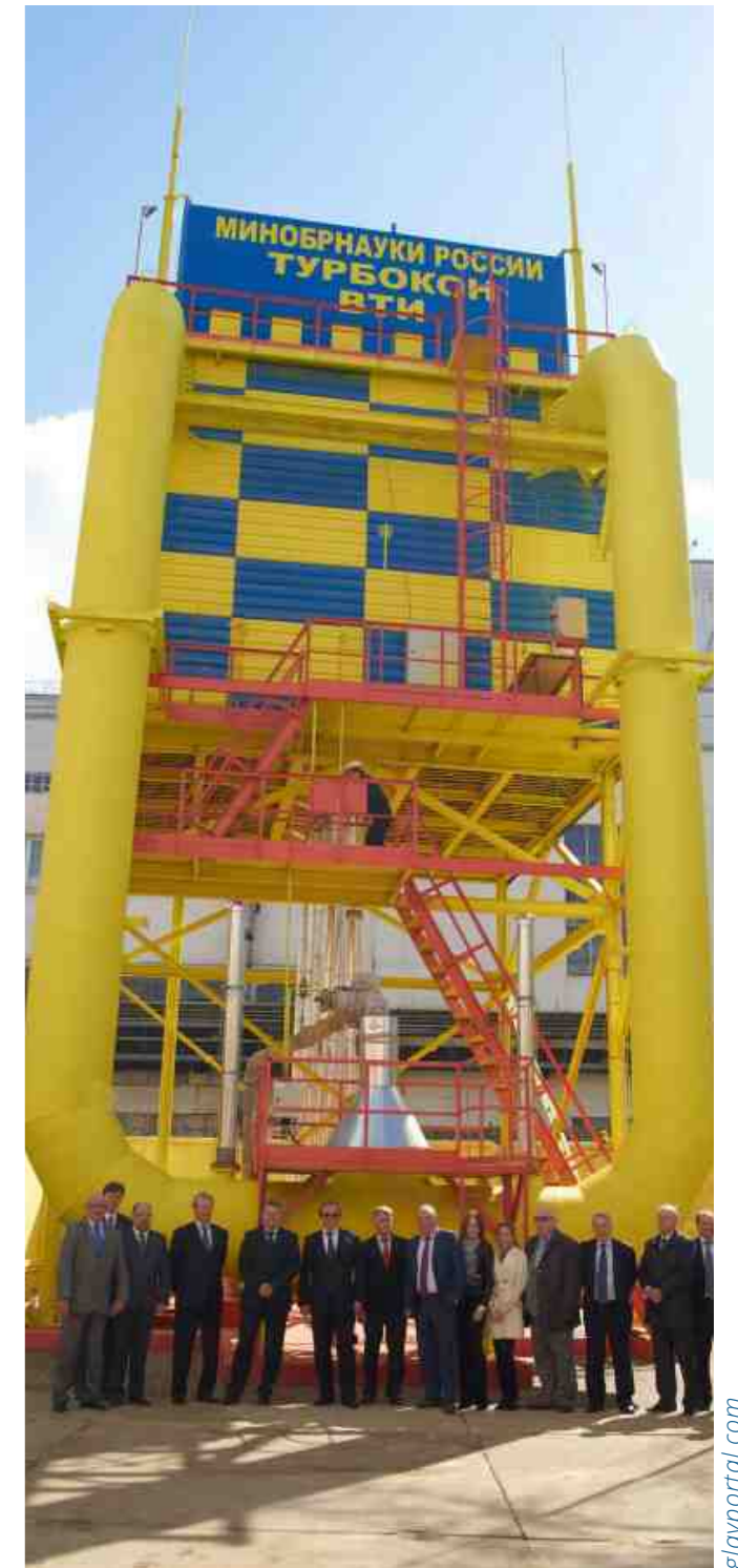
Блочный теплоутилизационный энергетический комплекс на компрессорной станции «Газпрома»
